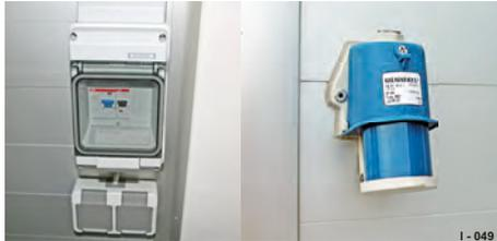
**Abb. 103** 230V-Anschluss / Sicherungsautomat innen
