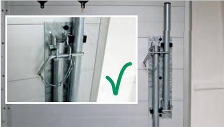
**Abb. 244** Sattelhalter eingeklappt und gesichert
