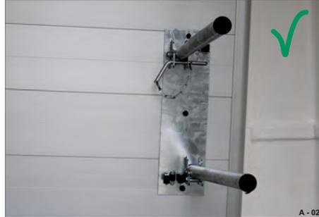
**Abb. 241** Sattelhalter ausgeklappt und gesichert
