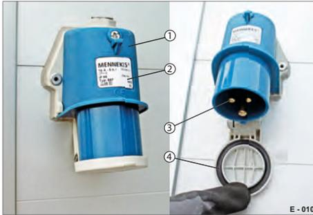
Abb. 366 Steckeranschluss, außen
