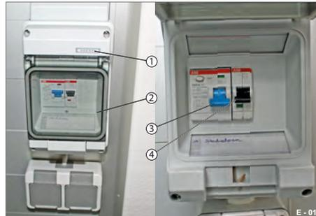
Abb. 368 Stromverteilerkasten / Sicherungsautomat
